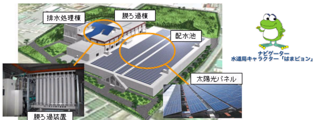
P F I を活用した再整備を進める川井浄水場
