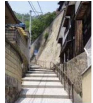
手すりの整備例 (千光寺新道)
