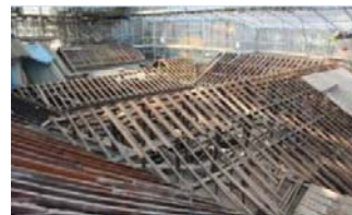
浄土寺の保存修理 (庫裏及び客殿)
