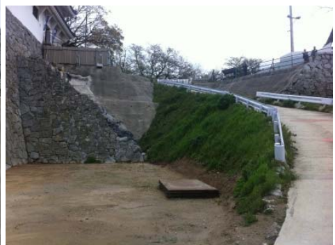
搬入路設置 (9面)
