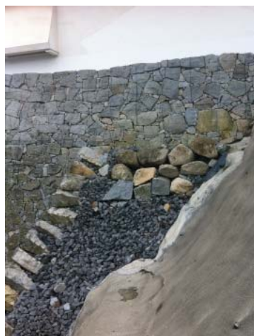
石垣解体面 (9面)
